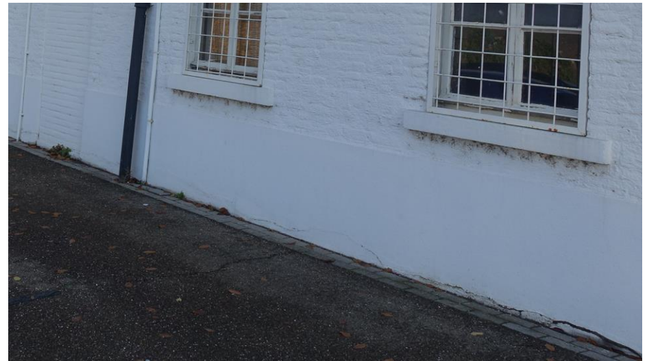
Fig. 7 De doorlopende plint is ten zuiden van de keermuur witgeverfd.
