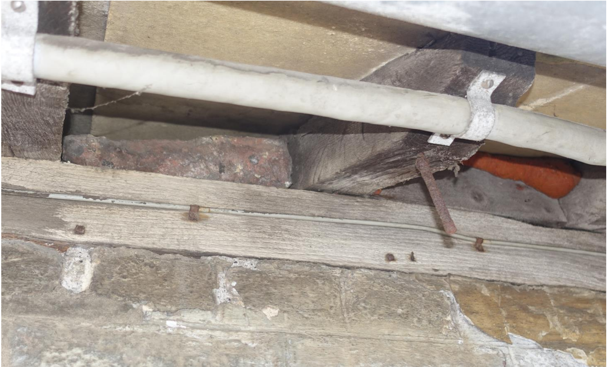
Zicht op de sporen aan de westzijde van het gebouw. Links van het spoor een strek als vulling, rechts een vurenhouten plaatje.
