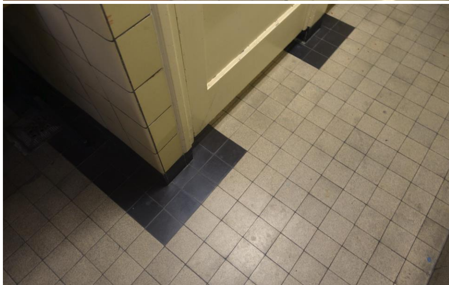
Afb 39 Detail tegellambrisering en vloer uit 1940 in ruimte H.
