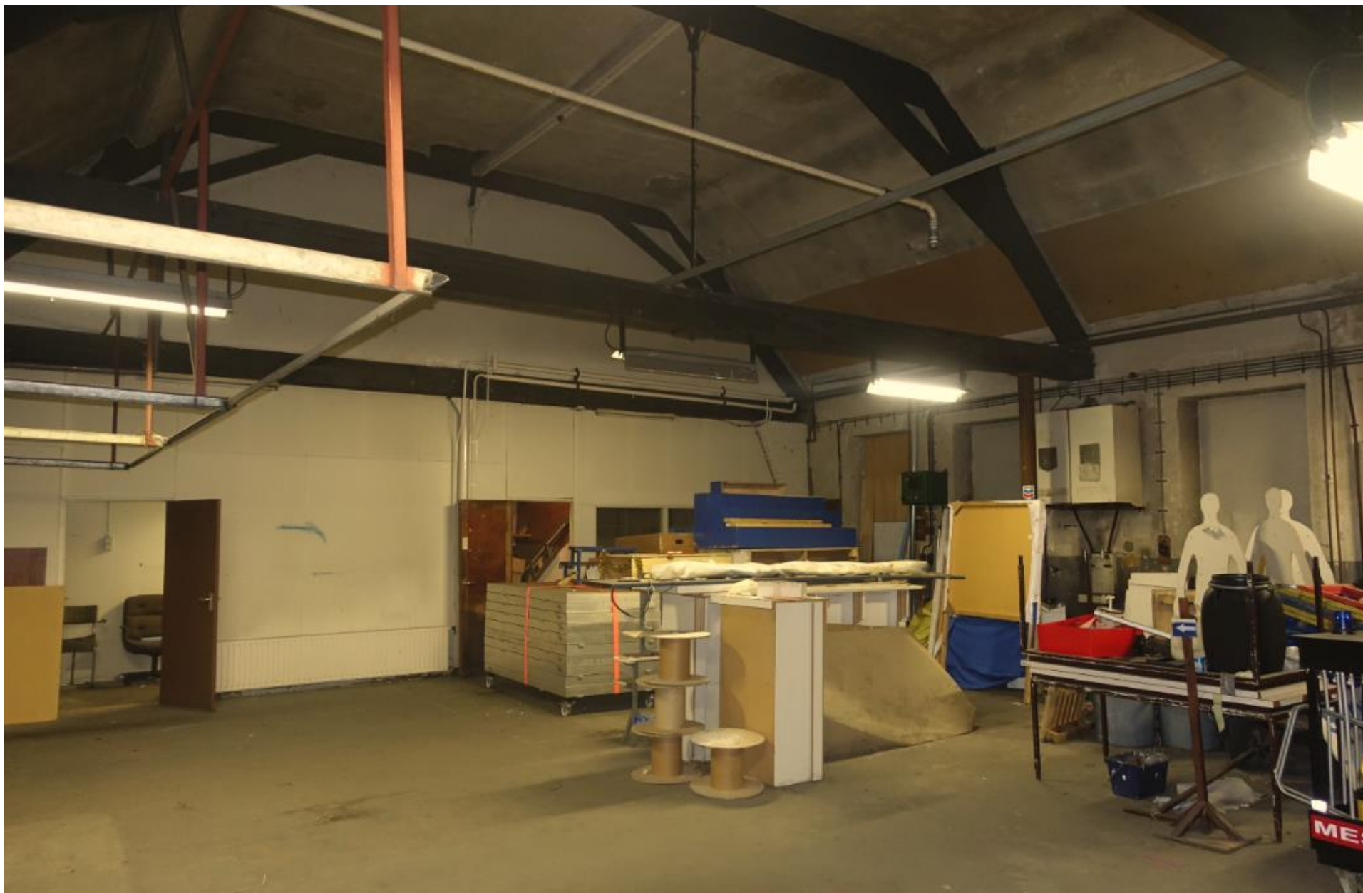
Afb 1 Ruimte A gezien naar de smalle ruimtes A1 en A2 tegen de zuidgevel.
