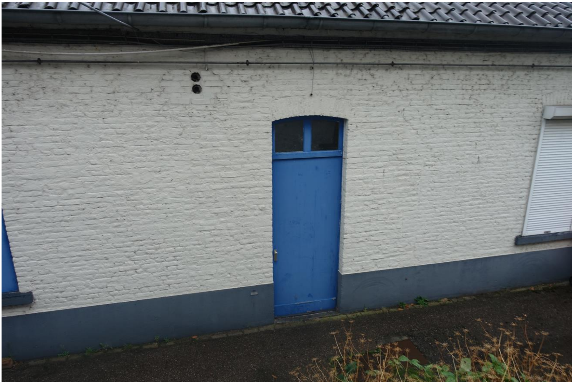
Fig. 32 De oude doorgang onder een rondboog in de oostgevel sluit aan op de positie van een soortgelijke dichtgezette doorgang in de westgevel. De vulling is van na 1940.
