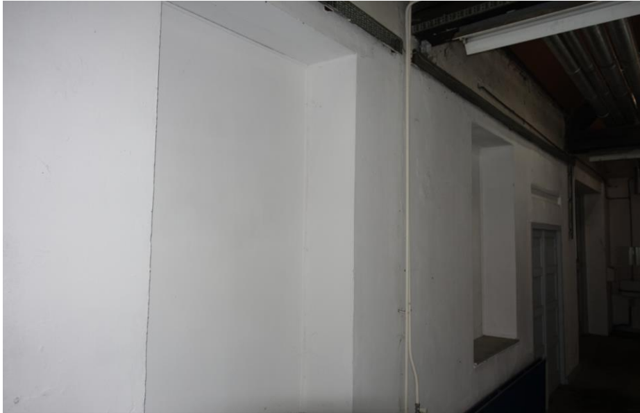
Fig. 33 De dichtgezette vensters in het noordelijke deel van de oostgevel, gezien vanuit gang l2 (zie plattegrond in hoofdstuk 3).
