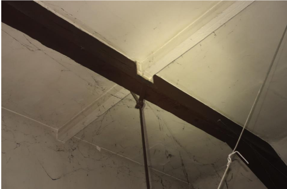
De bovenste dekbalken hebben in 1940 een versteviging in de lengte gekregen in de vorm van wit geschilderde houten balken. Deze foto is gemaakt boven ruimte G.
