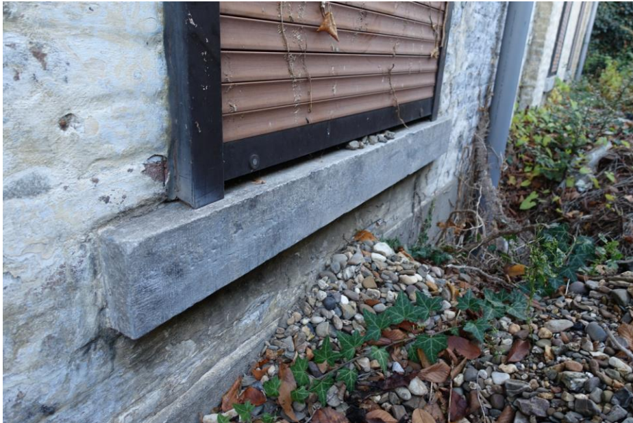
Fig. 12 Detail van een hardstenen lekdorpel bij een van de vensters in het noordelijke deel van de westgevel.
