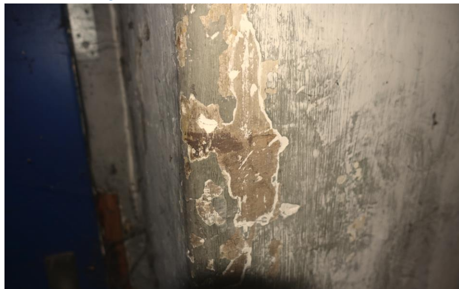
Afb 20 Detail geschilderde lambrisering uit 1940 in ruimte D.
