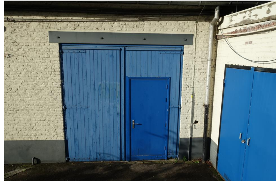
Fig. 42 De meest noordelijke doorgang in de oostgevel is een toevoeging van na 1965, die in vorm en opzet geheel afwijkt van de bestaande openingen in de gevel.
