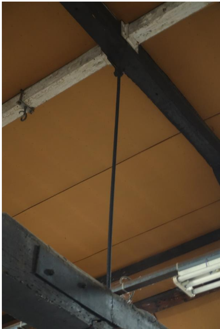
Afb 45 Detail ankersysteem uit 1940 bij de kapconstructie boven ruimte I.
