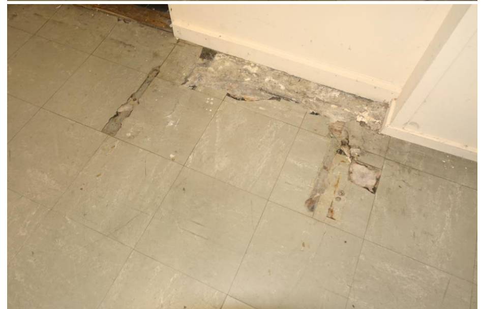
Afb 32 Details lambrisering en vloertegels in ruimte G.
