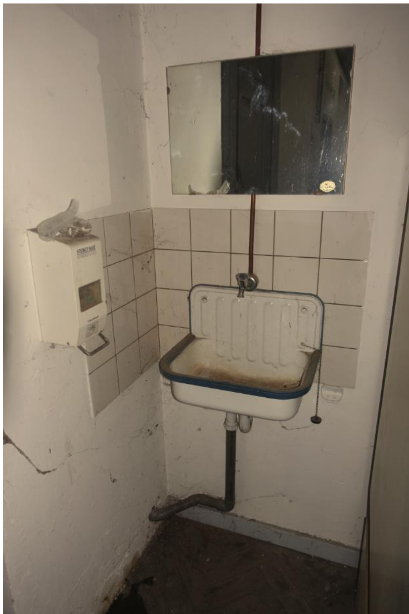
Afb 50 Wasbak in ruimte I2.
