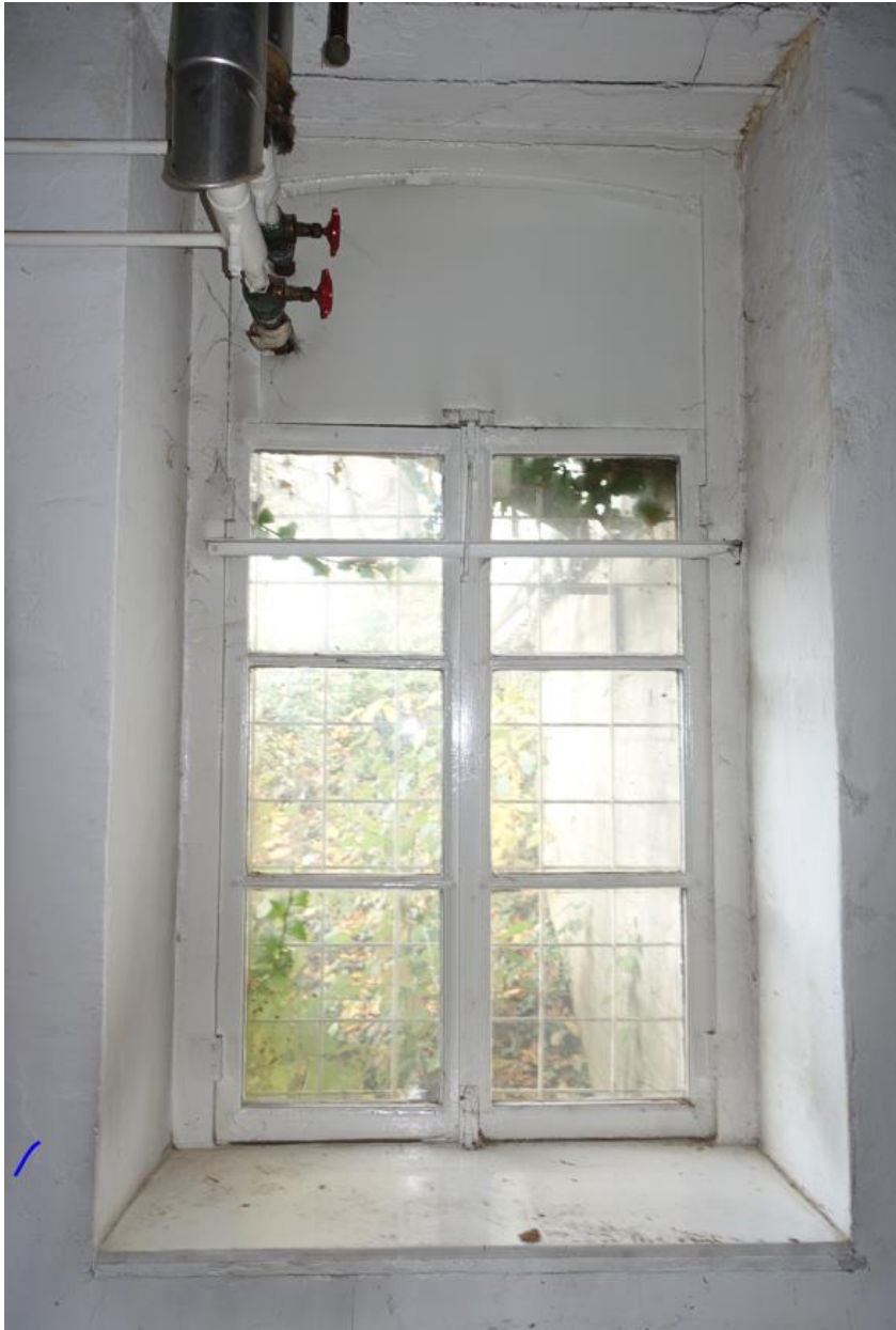
Fig. 21 Een 6-ruits draairaam uit 1878 in de westgevel.
