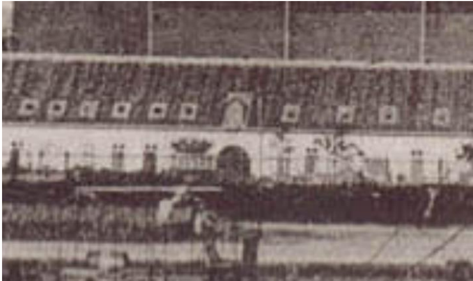
Uitsnede uit een foto van omstreeks 1905 van de westgevel van de loods met duidelijk zichtbaar de opening met rondboog. Afb: RHCL beeldbank, nr. 12467.
