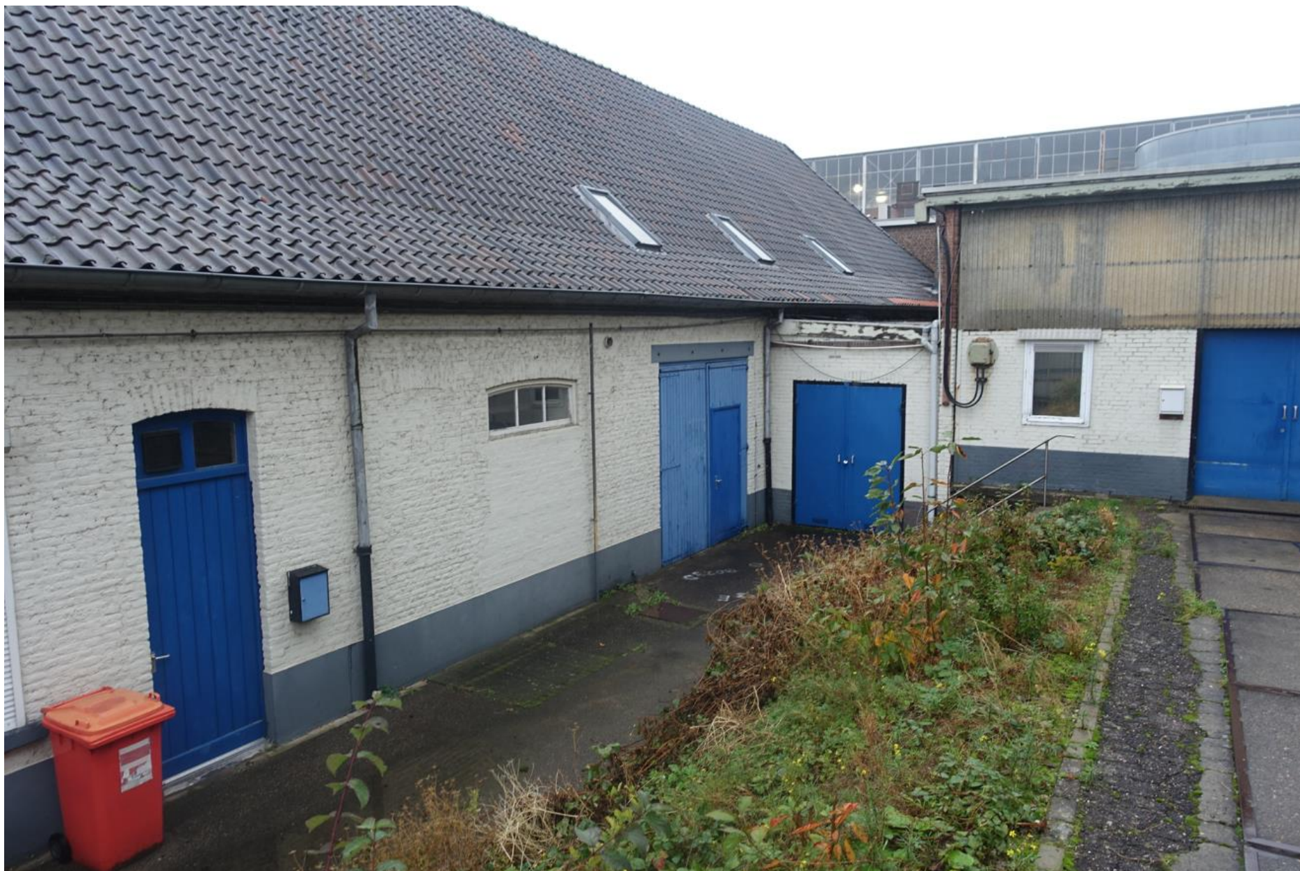
Fig. 29 De oostgevel gezien richting het noorden waar een bouwdeel tegen de gevel van de voormalige affuitenloods is gesitueerd.
