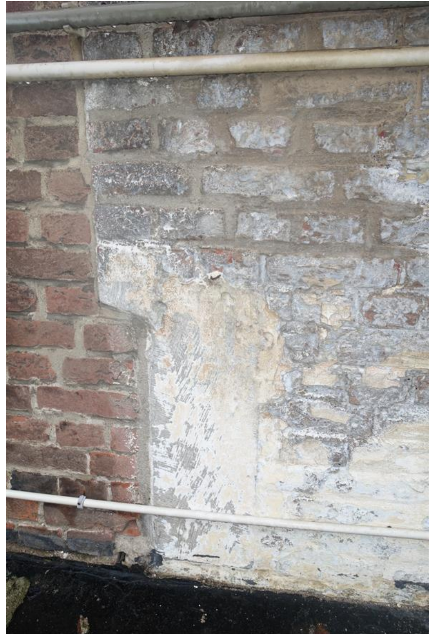
Fig. 10 Detail van het hardstenen blok op de hoek met de noordelijke kopgevel.
