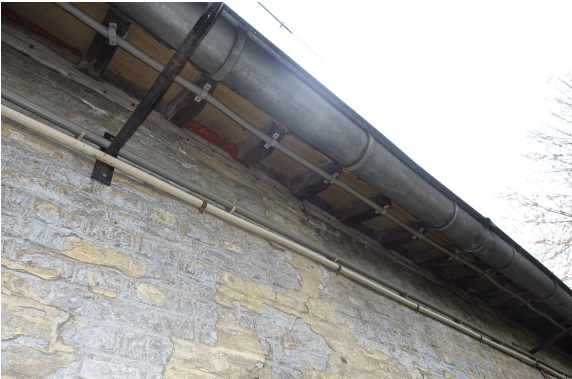
Zicht op de doorstekende daksporen aan de westzijde van het gebouw. De sporen rusten op een muurplaat.
