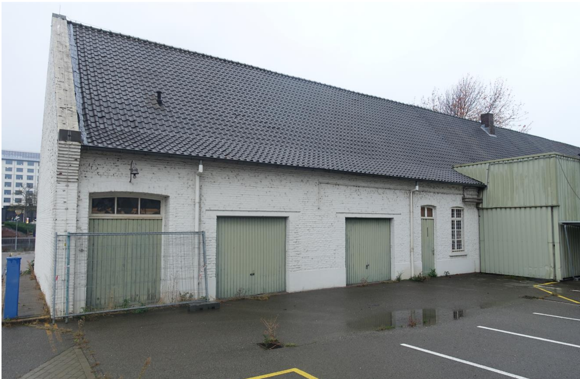
Fig. 27 De zuidelijke helft van de oostgevel.
