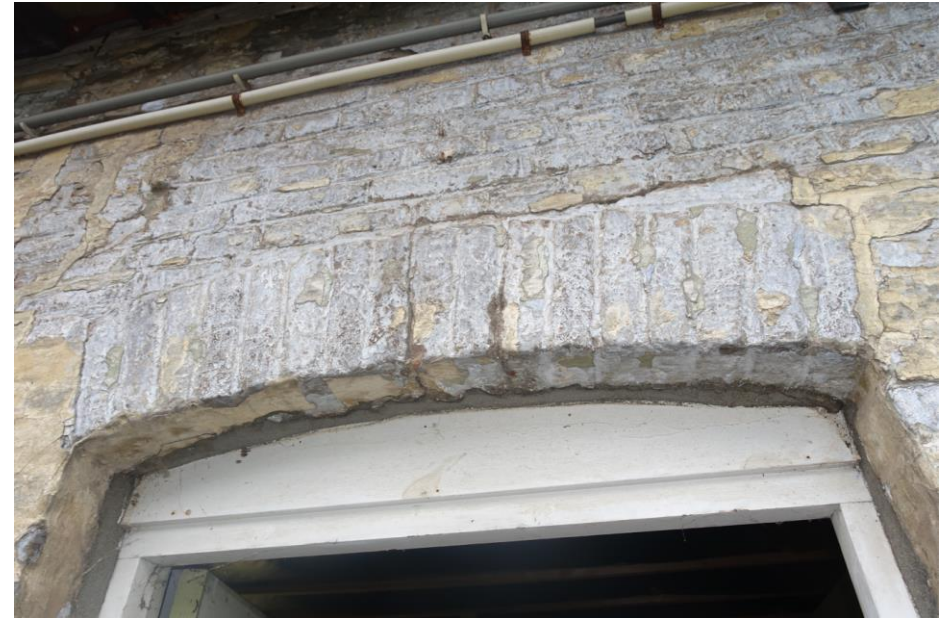
Fig. 13 Detail van een segmentboog boven de meest noordelijke doorgang in de westgevel.
