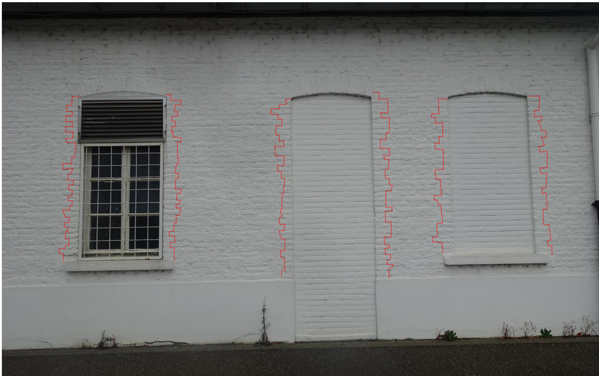
Fig. 14 Gevelopeningen uit 1878 in de westgevel met bij rood het inboetwerk.
