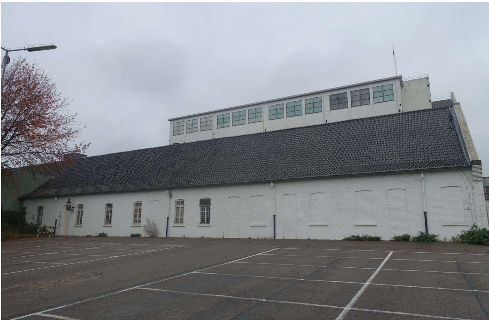
Fig. 3 Het zuidelijke deel van de westgevel met uiterst links de keermuur van damwandstaal.
