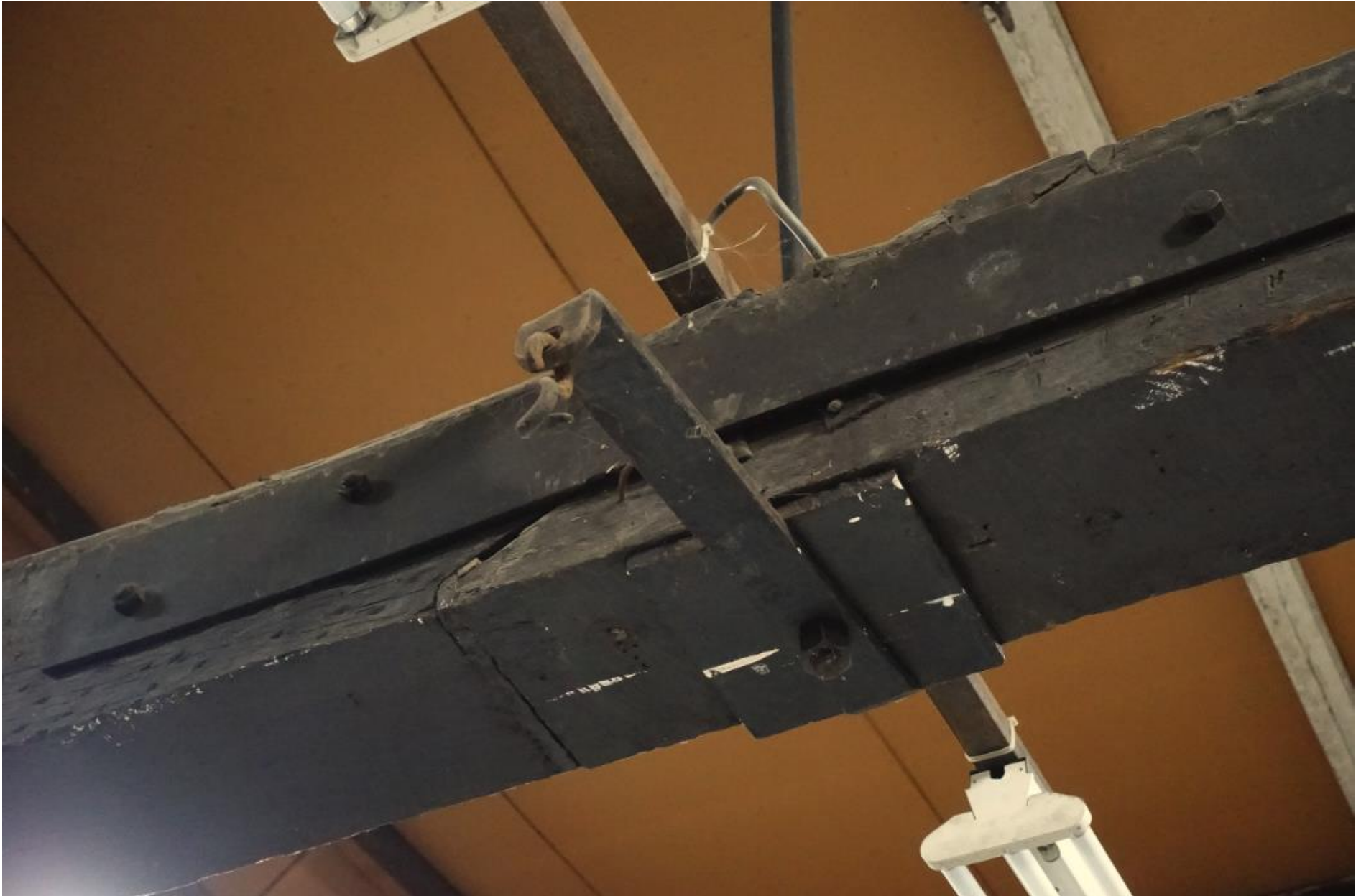
Detail van koppeling uit 1940 van de onderste dekbalken bij een van de spanten. De koppeling bestaat uit een ijzeren staafanker die vastgeschroefd is in de balken uit 1827. Ook de ijzeren platen zijn uit 1940. De dekbalken zijn van oorsprong opgedeeld in twee delen, herkenbaar aan de laslijn.
