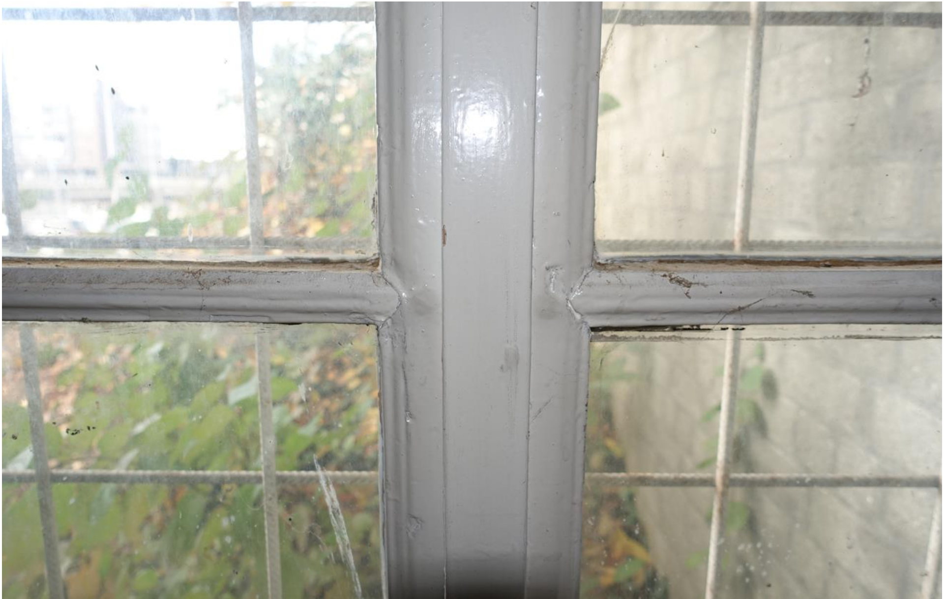
Fig. 23 Detail van de profilering van de ramen uit 1878.
