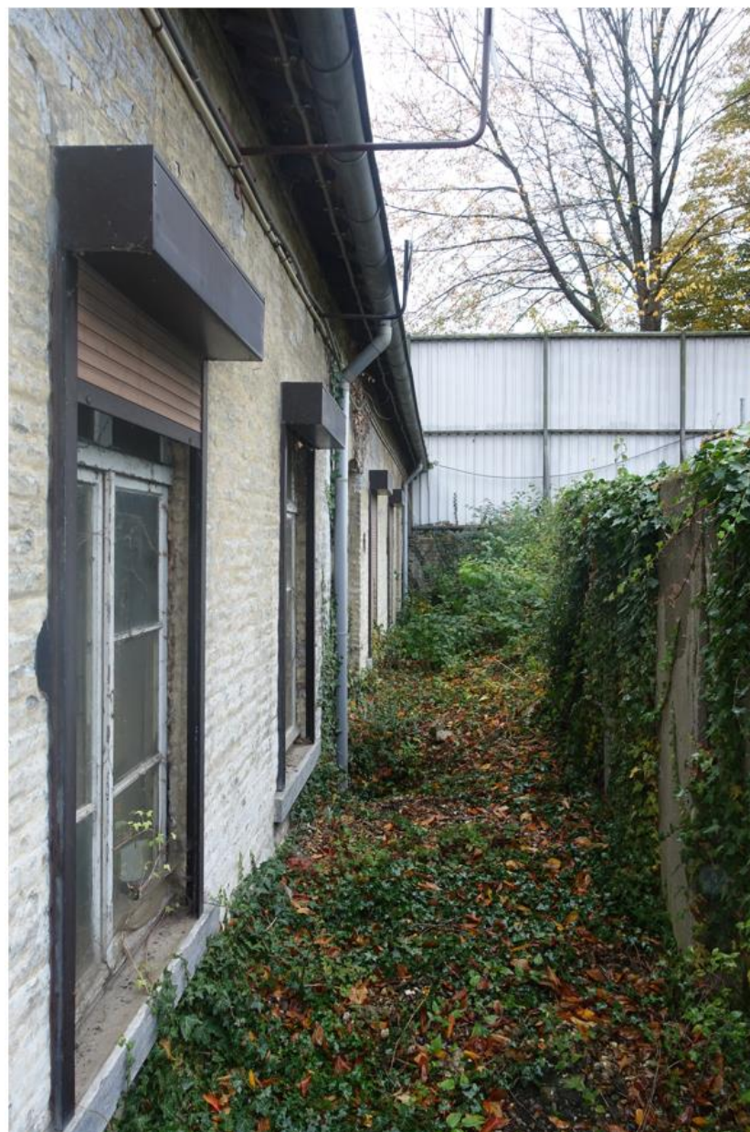
Fig. 2 Westgevel gezien naar het zuiden richting de keermuur.
