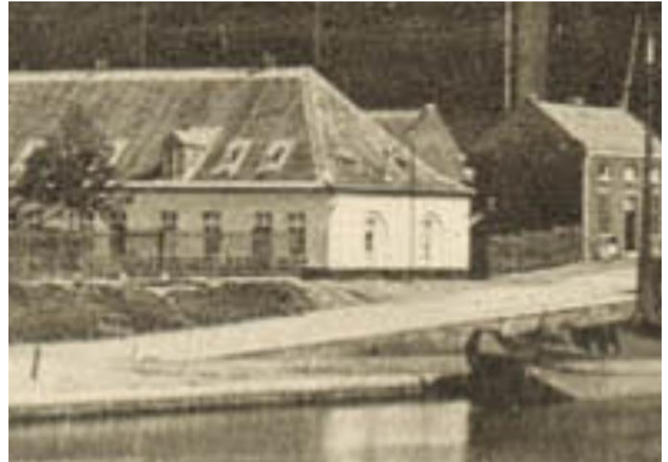
Uitsnede uit een foto van de loods uit ca. 1905. In de zuidelijke kopgevel zijn twee rondbogen te zien. Afb: RHCL beeldbank, nr. 5440.
