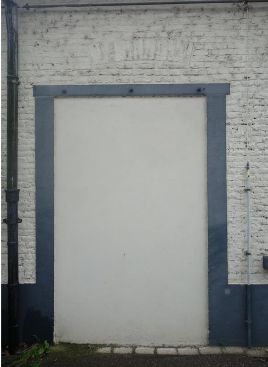
Fig. 38 Een later verbrede opening uit 1878, herkenbaar aan de segmentboog die zichtbaar is boven de dichtgezette doorgang.
