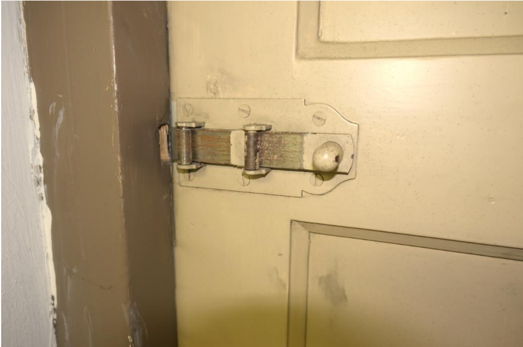
Afb 17 Detail sluiting uit 1940 bij de doorgang tussen ruimte C2 en D.
