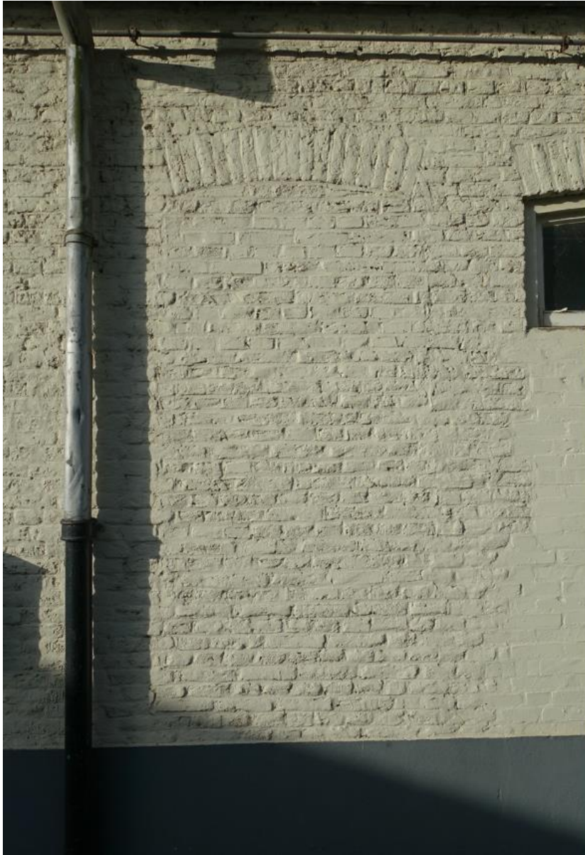
Fig. 36 Een dichtgezette gevelopening uit 1878.
