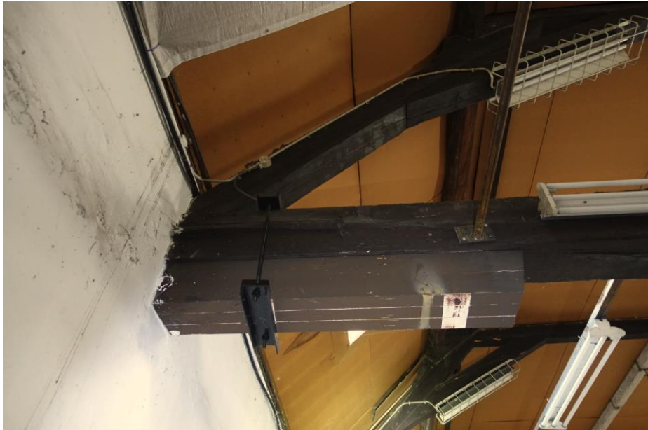
Aan de westzijde hebben de onderste dekbalken in 1940 een houten slof gekregen ter ondersteuning van de constructie.
