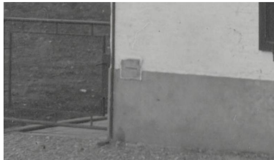
Uitsnede uit de foto van 1941 van de zuidgevel met op de hoek het hardstenen blokje. Dit blok is na het vernieuwen van de gevel in 1979 opnieuw ingemetseld. NA, Collectie / Archief Fotocollectie Arbeidsinspectie, Archiefnr. 2.24.03, inv.nr 1183.
