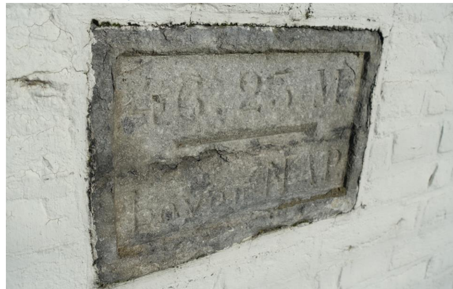
Detail van het hardstenen blok in de zuidgevel die een hoge waterstand aangeeft.
