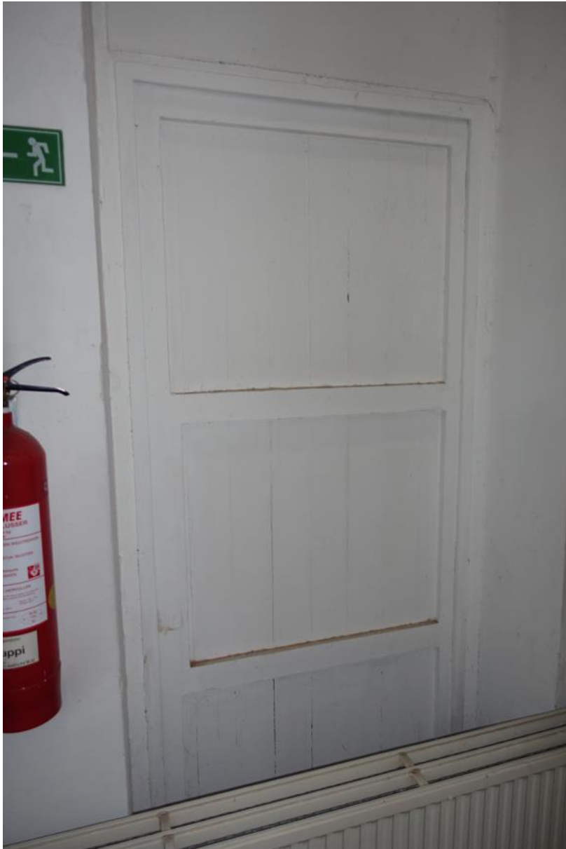
Fig. 41 De binnenzijde van een opgeklampte deur uit 1940.
