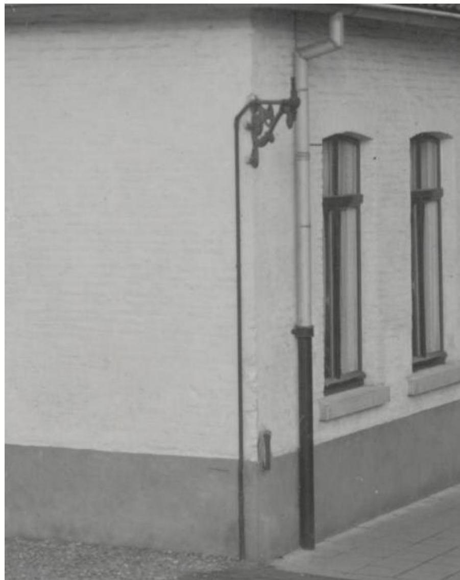
Detail van de afbeelding uit 1941 van de zuidgevel met op de hoek een oude aansluiting van een gaslantaarn. De krul komt qua detaillering overeen met de krul zoals die bij de lantaarn tegen de westgevel is aangetroffen. NA, Collectie / Archief Fotocollectie Arbeidsinspectie, Archiefnr. 2.24.03, inv.nr 1183.
