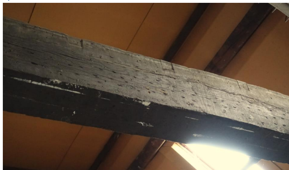
Detail van een onderste dekbalk waar aan de bovenzijde de kepen waarin de verdwenen kinderbinten van de oorspronkelijke zoldervloer lagen goed zichtbaar zijn.
