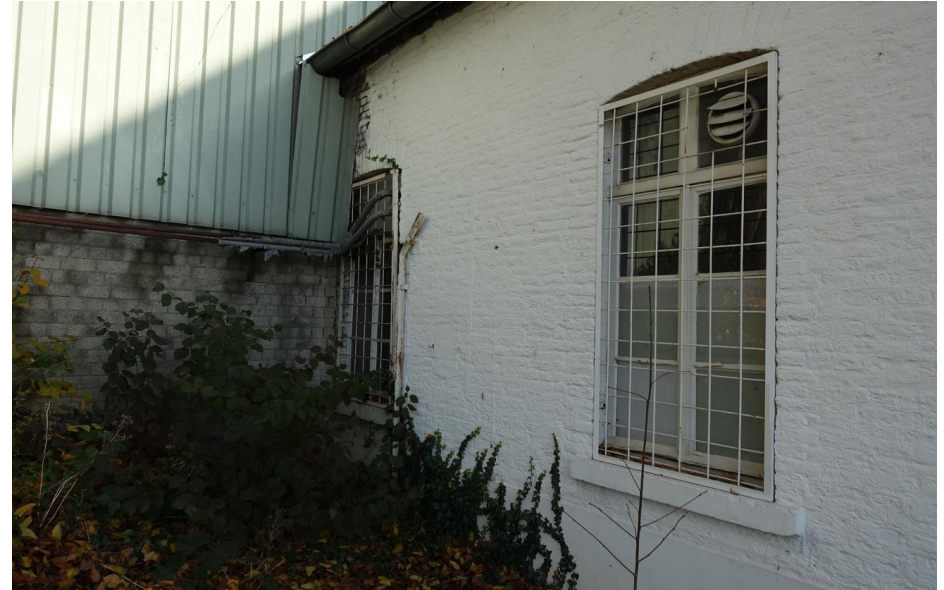
Fig. 6 De aansluiting van de keermuur op de westgevel gezien richting het noorden.
