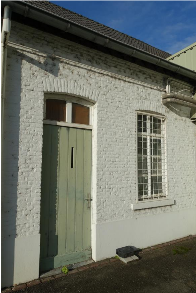
Fig. 35 De twee oude openingen uit 1878 in het zuidelijke deel van de oostgevel. De opgeklampte deur is van 1940.
