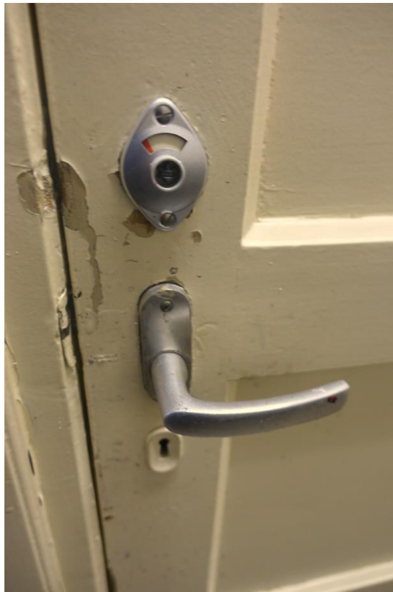
Afb 40 Detail sluitwerk in de toiletdeur in ruimte H.
