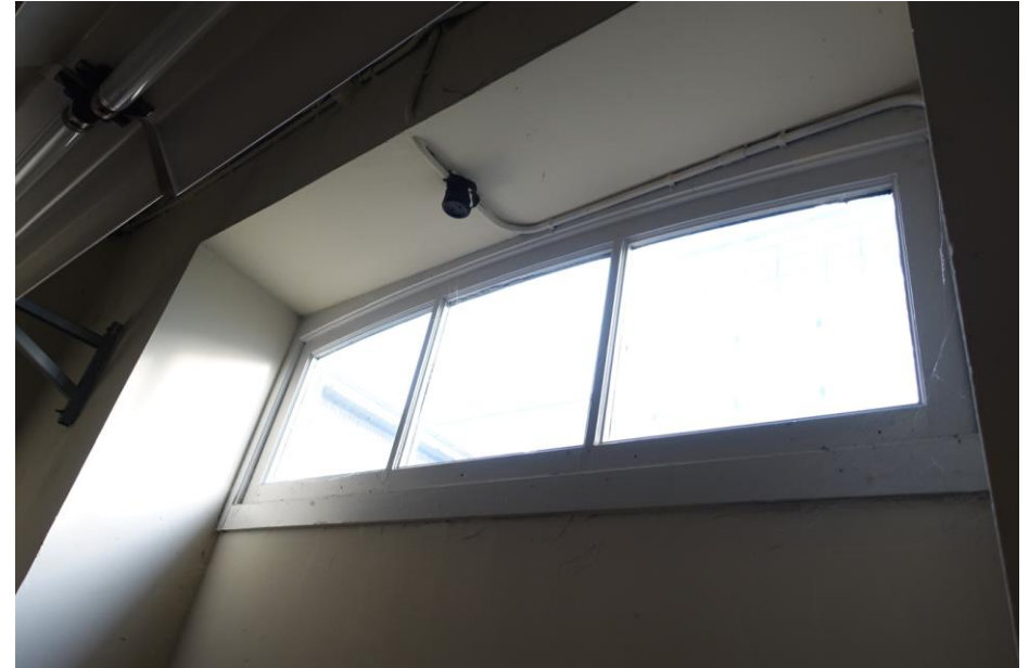
Fig. 39 Een van de bovenlichten uit 1940 in de oostgevel.
