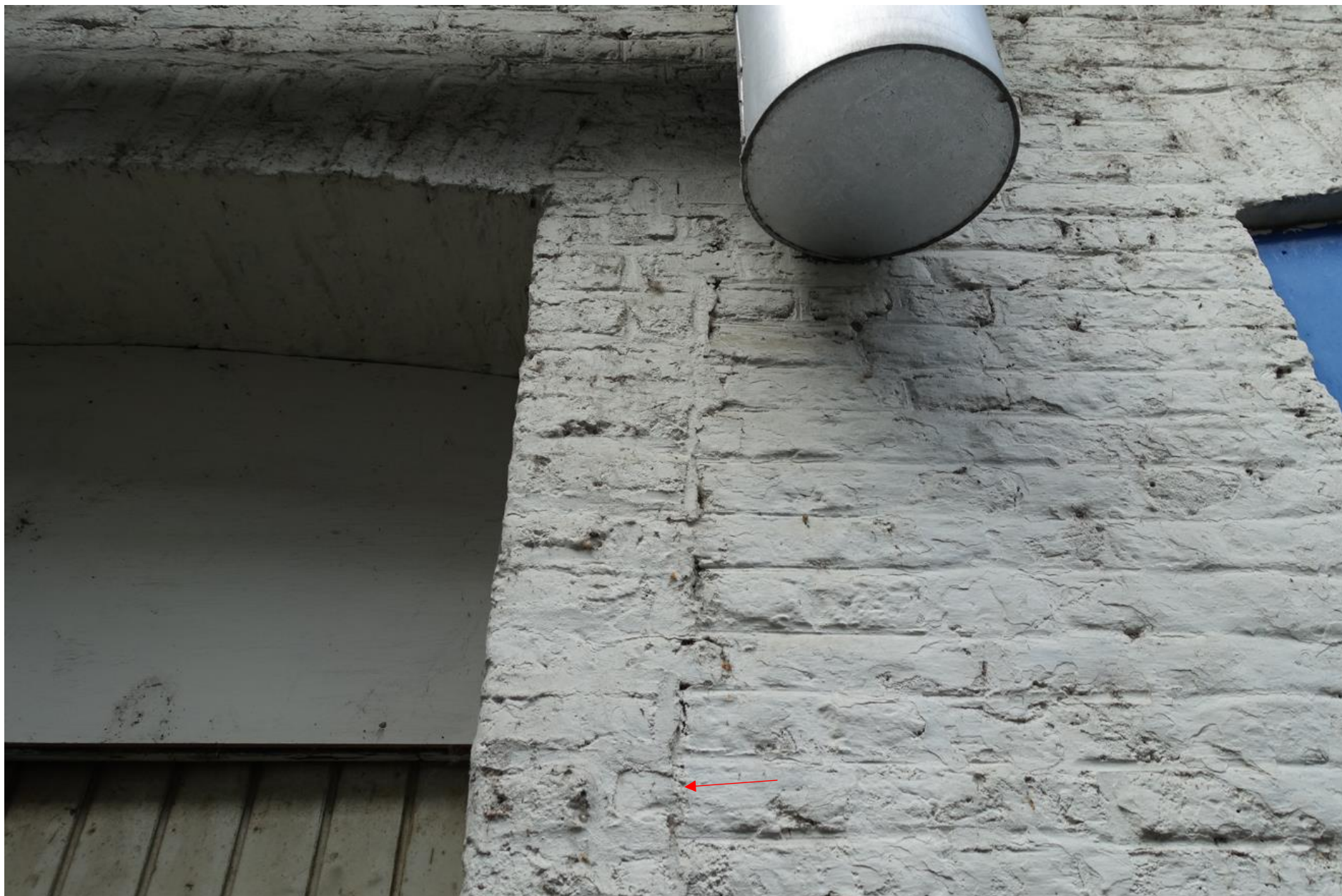
Fig. 42 Rond de opening van 1940 is het inboetwerk heel duidelijke zichtbaar (rode pijl) dat bijna als een rechte naad omhoog loopt.
