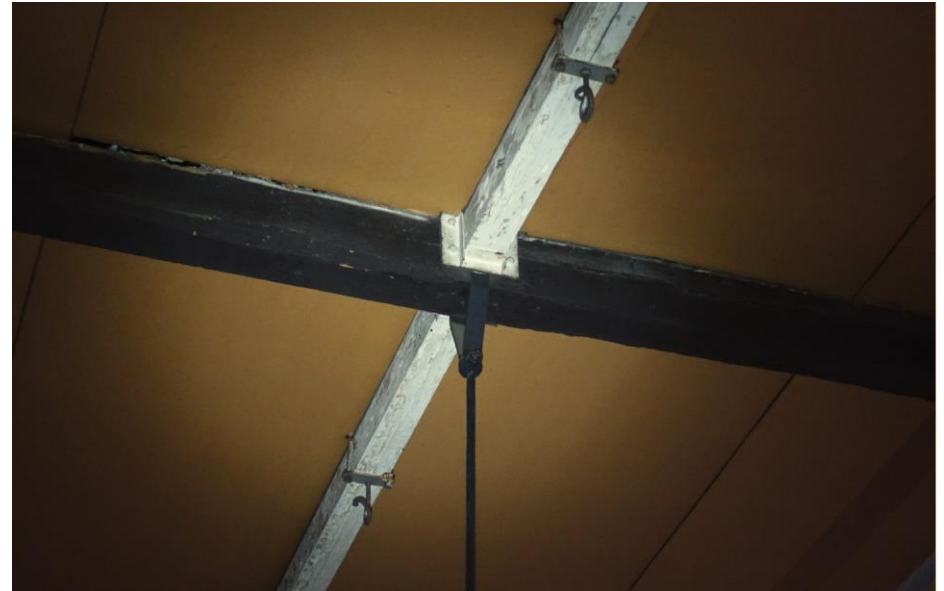
Detail van de geschroefde bevestiging van de staafanker aan de bovenste dekbalk.
