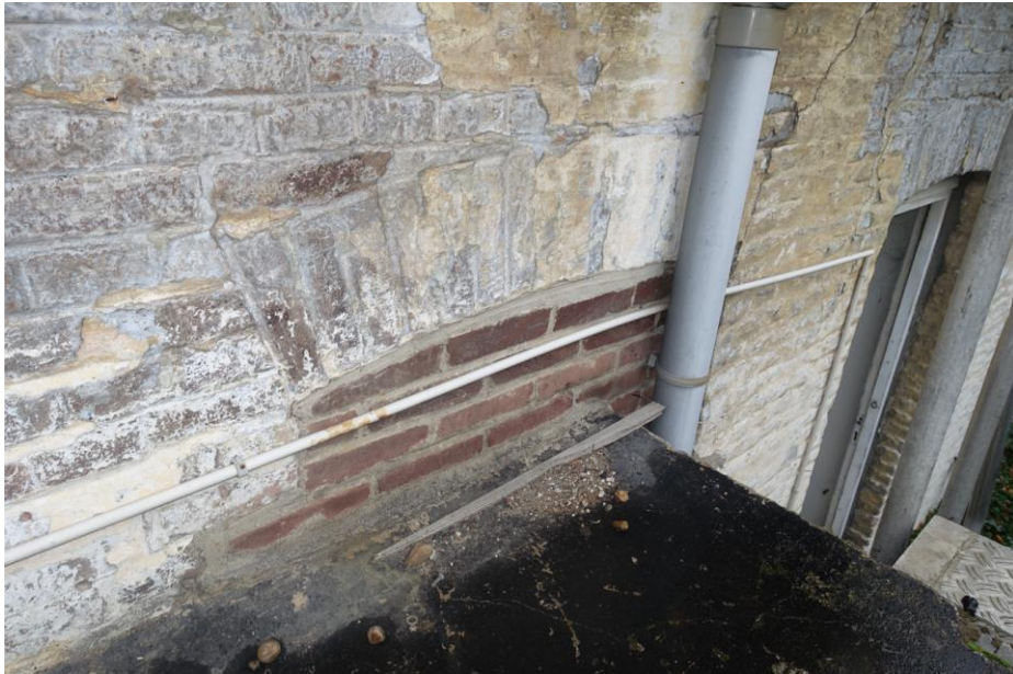
Fig. 9 De aansluiting van het opgehoogde terrein op het noordelijke deel van de westgevel.
