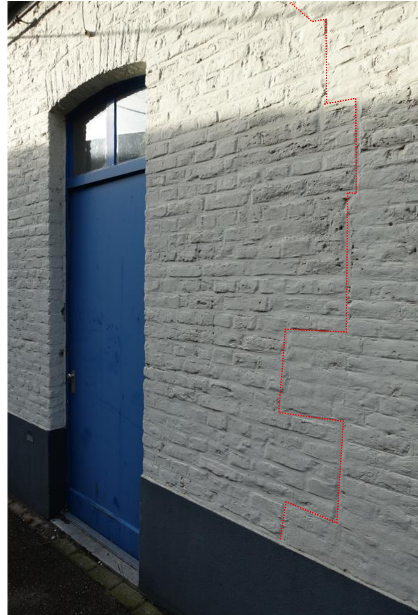
Fig. 31 Detail van de bouwnaad bij de dichtgezette doorgang onder een rondboog.
