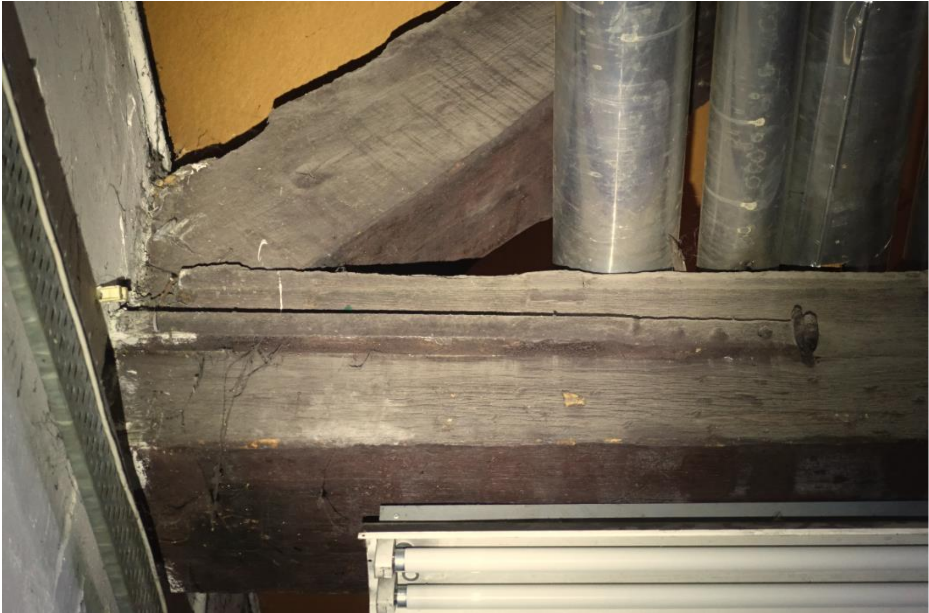
De onderste dekbalken zijn met ijzeren staven in de gevel verankerd. De staaf is op het uiteinde vastgenageld in de dekbalk. Deze constructie stamt uit 1827.
