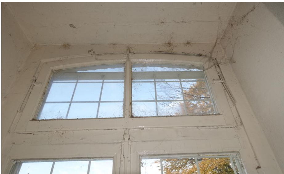
Fig. 18 Detail van een bovenlicht gezien van binnenuit met oud sluitwerk, wellicht uit 1878.
