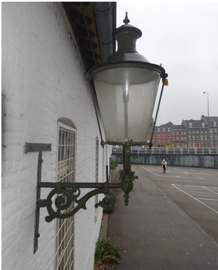
Fig. 24 De lantaarn bij een van de toegangen tot het gebouw in de westgevel. Mogelijk stamt deze lantaarn uit de 19 de eeuw. Het onderste deel van de lantaarn was ooit gepositioneerd op de hoek met de zuidgevel.
