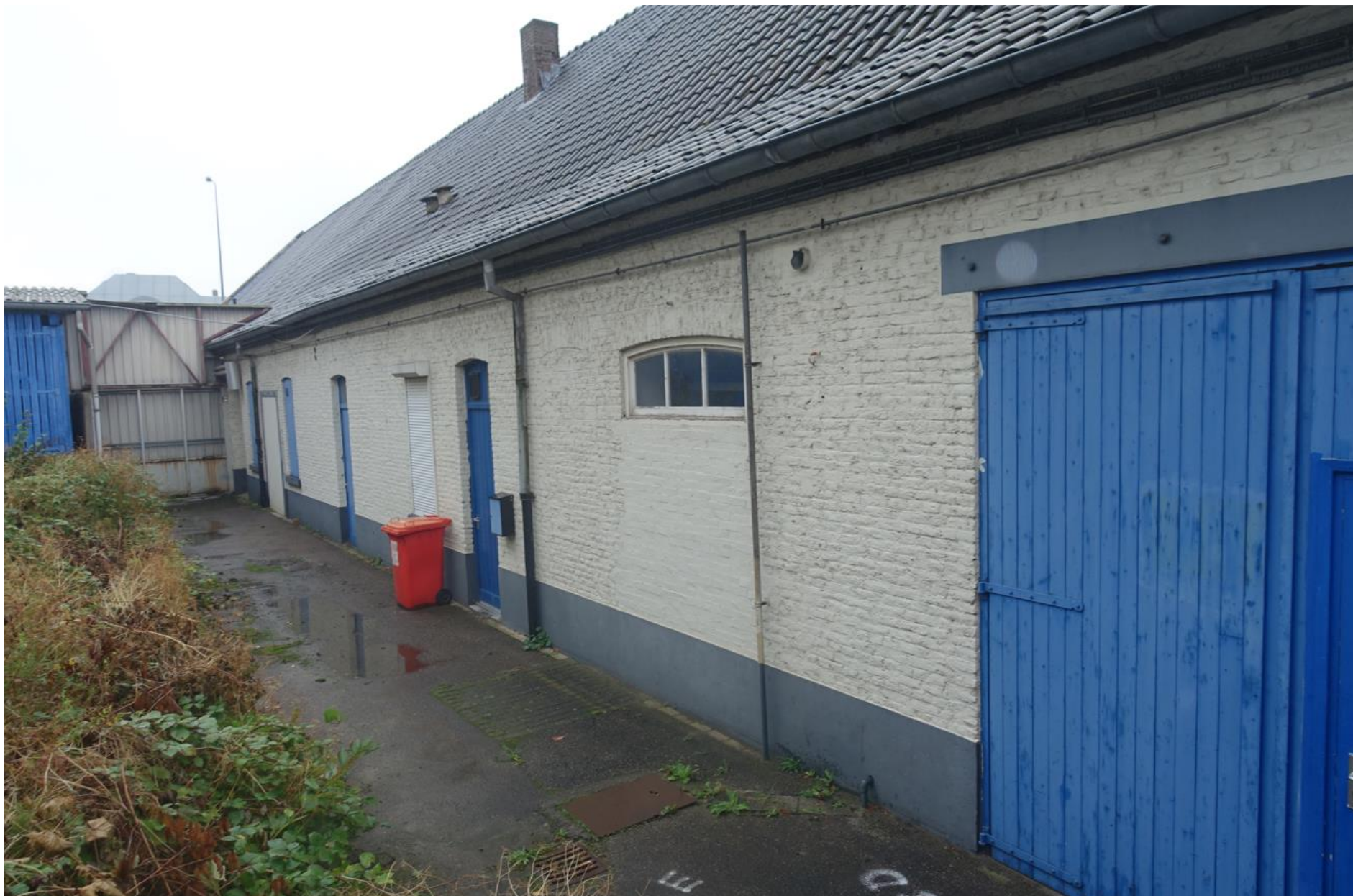
Fig. 28 De noordelijke helft van de oostgevel gezien richting de poort van damwandstaal.
