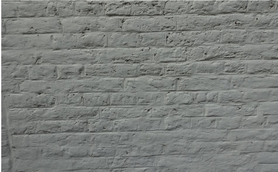
Fig. 30 Detail van het oorspronkelijke metselwerk in de oostgevel, voorzien van gesneden voegen.
