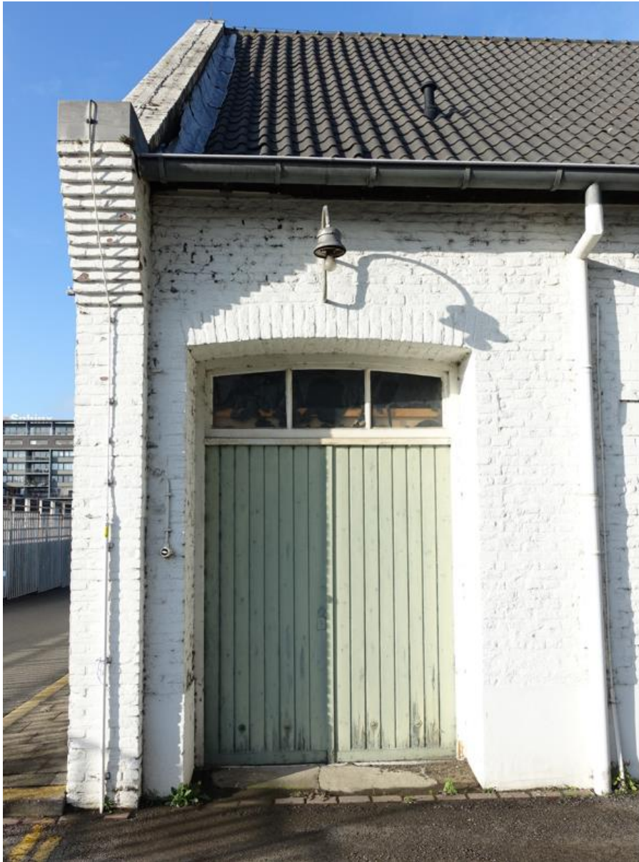
Fig. 40 De opening met dubbele deuren uit 1940. Boven de doorgang een lantaarn uit 1940.
