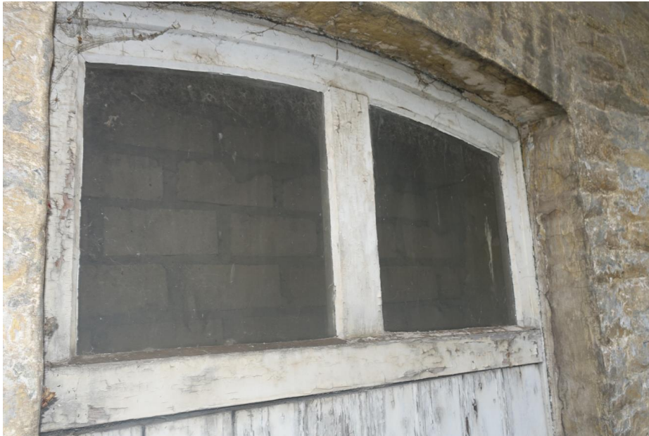
Fig. 17 Detail van een uit 1878 stammend bovenlicht.
