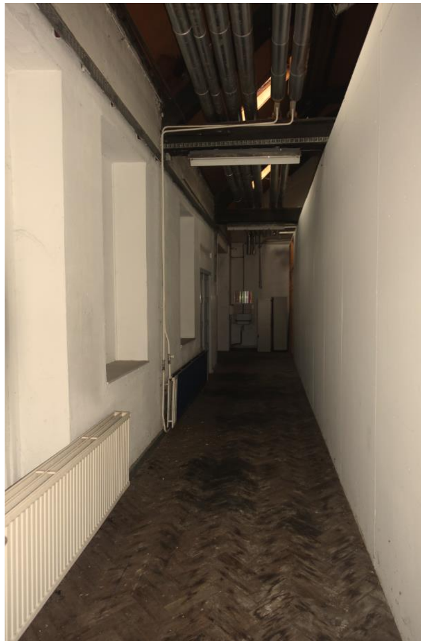
Afb 49 Ruimte I2 richting I1.
