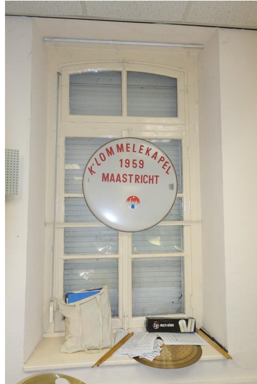
Fig. 34 Een oud 6-ruits draairaam uit 1878 in de oostgevel.
