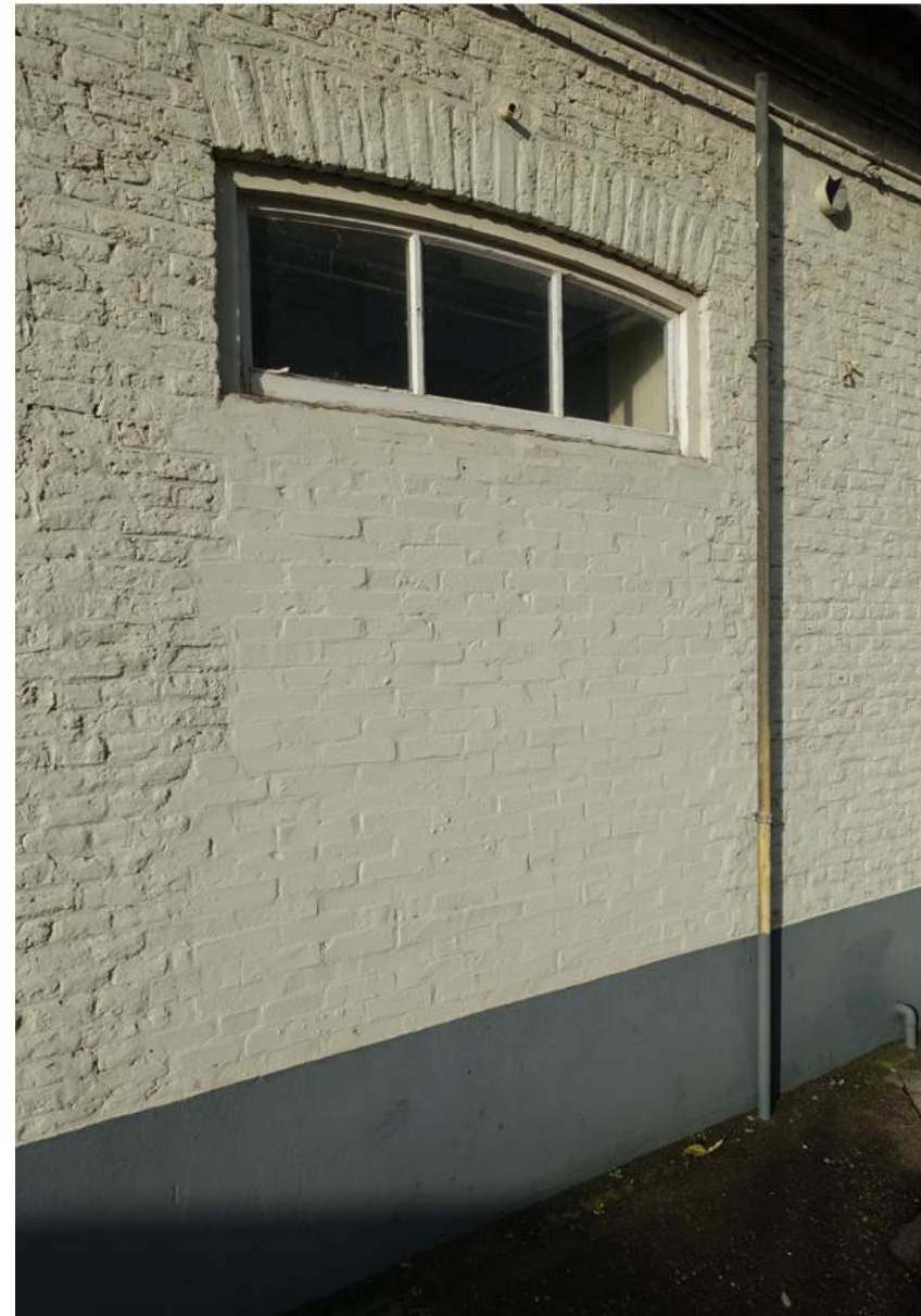
Fig. 41 De meest noordelijke opening uit 1940 in de oostgevel is dichtgezet met uitzondering van het bovenlicht.
