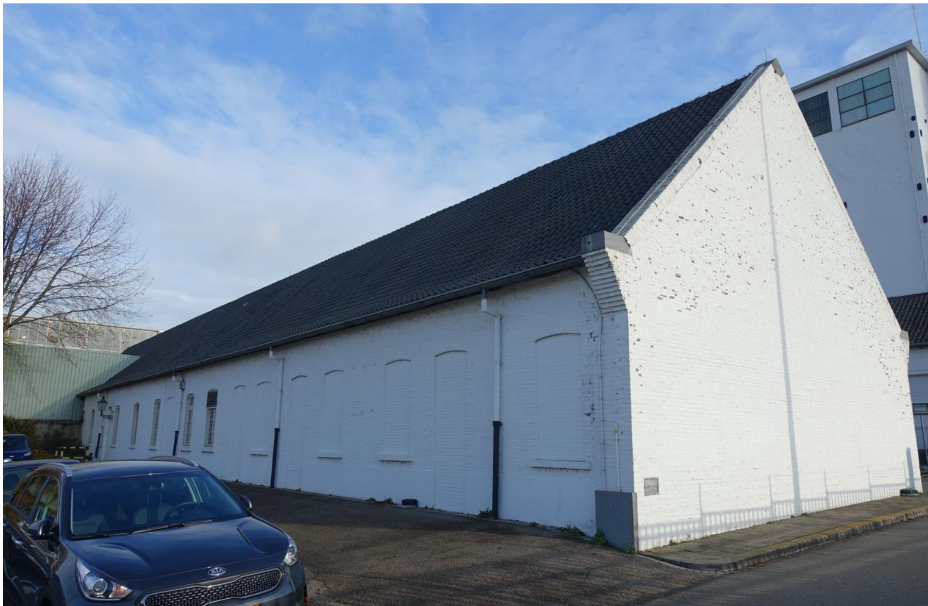
Fig. 8 De westgevel is aan de zuidzijde ingekort. Van oorsprong was het gebouw enkele meters langer en had het dak een schild, zoals aan de noordzijde.
