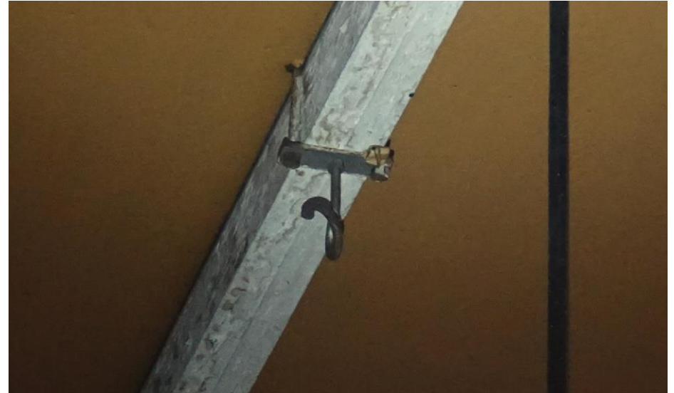
Detail van een ijzeren haak die ter hoogte van ruimte I aan de dubbele balk tussen de bovenste dekbalken is bevestigd. Aan de haak konden gymnastiektoestellen worden gehangen.
