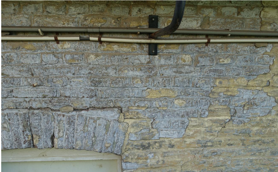
Fig. 5 Detail van het metselwerk van de westgevel.
