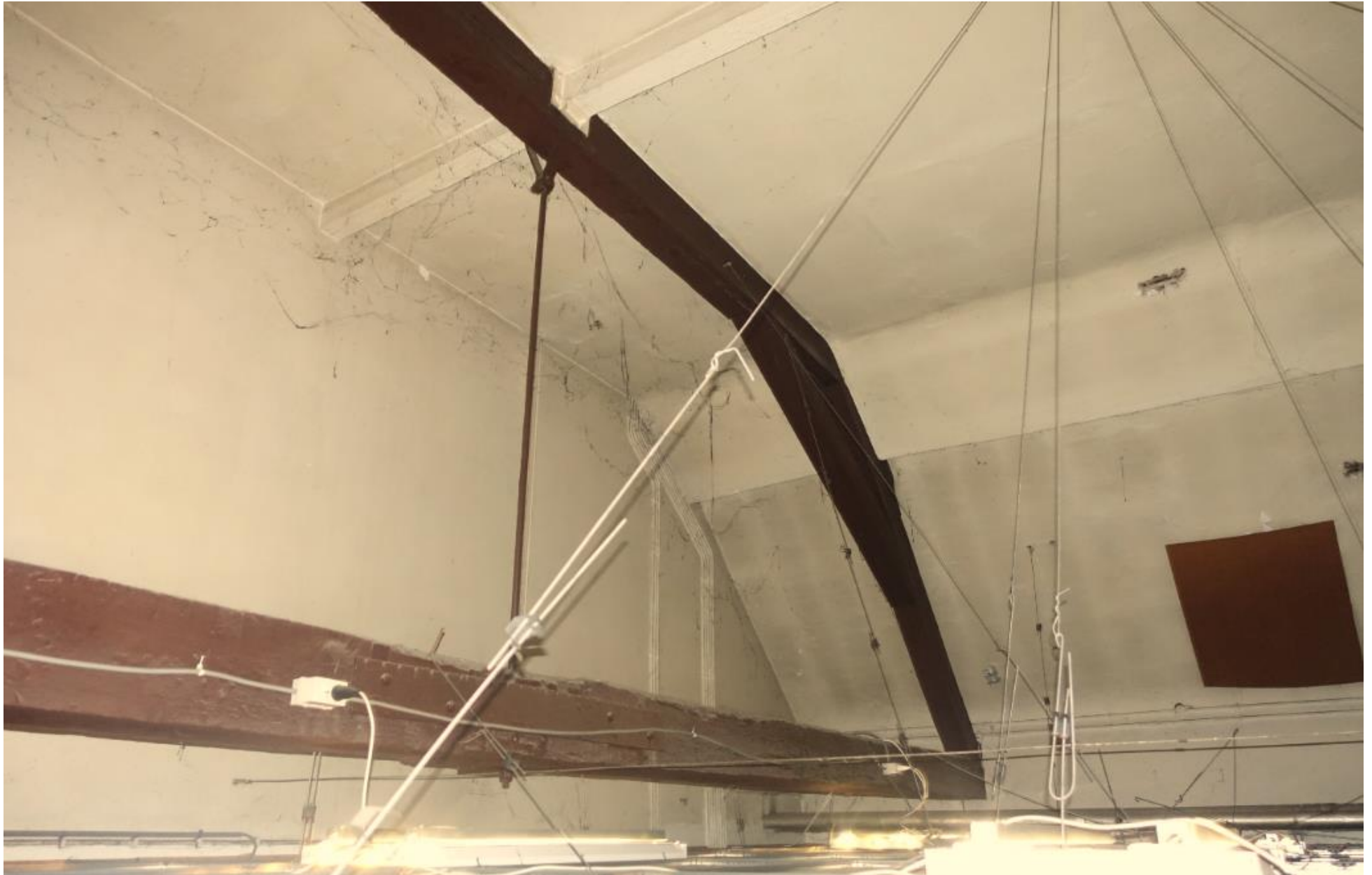
Afb 35 Kapconstructie boven ruimte G met stucwerk op tengels uit 1940.
