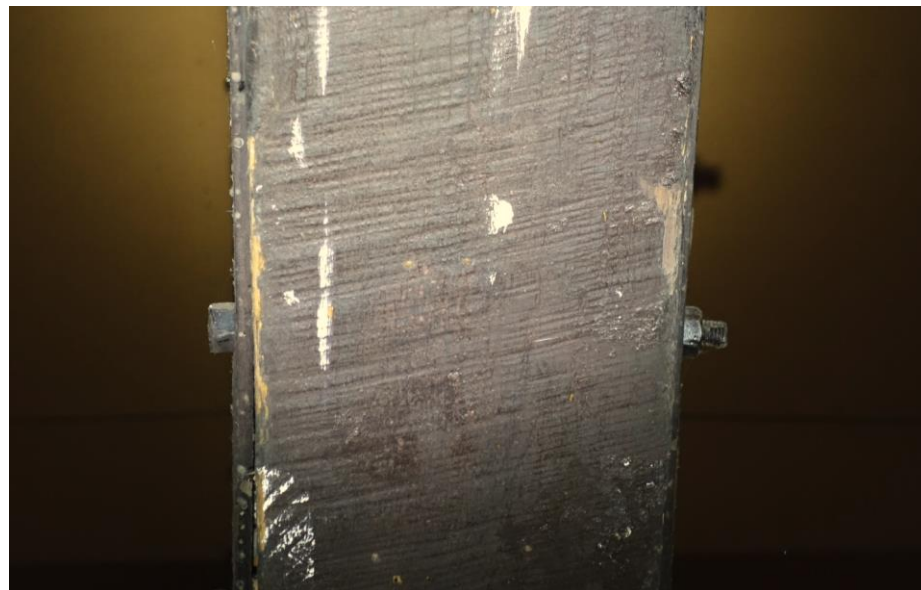
Detail van de onderzijde van een onderste dekbalk waar de zaagsporen duidelijk zichtbaar zijn.
