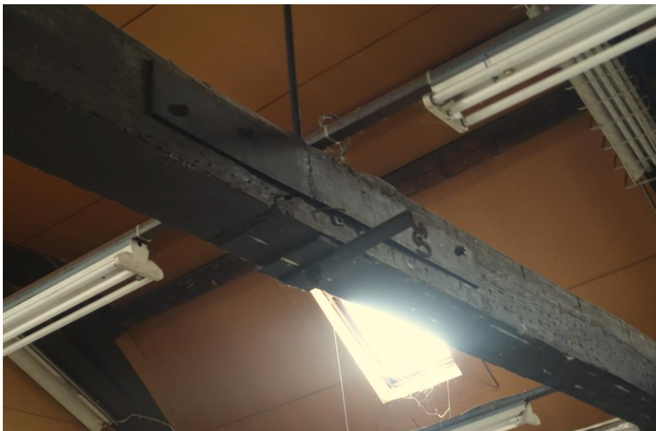
Afb 44 Detail ankersysteem uit 1940 bij de kapconstructie boven ruimte I.
