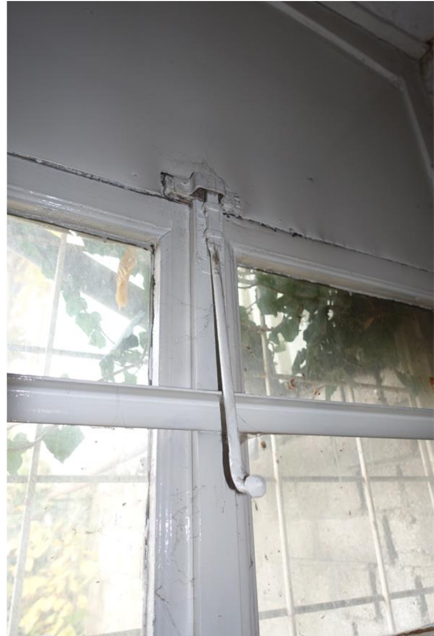
Fig. 22 Detail van sluitwerk bij een bovenlicht.
