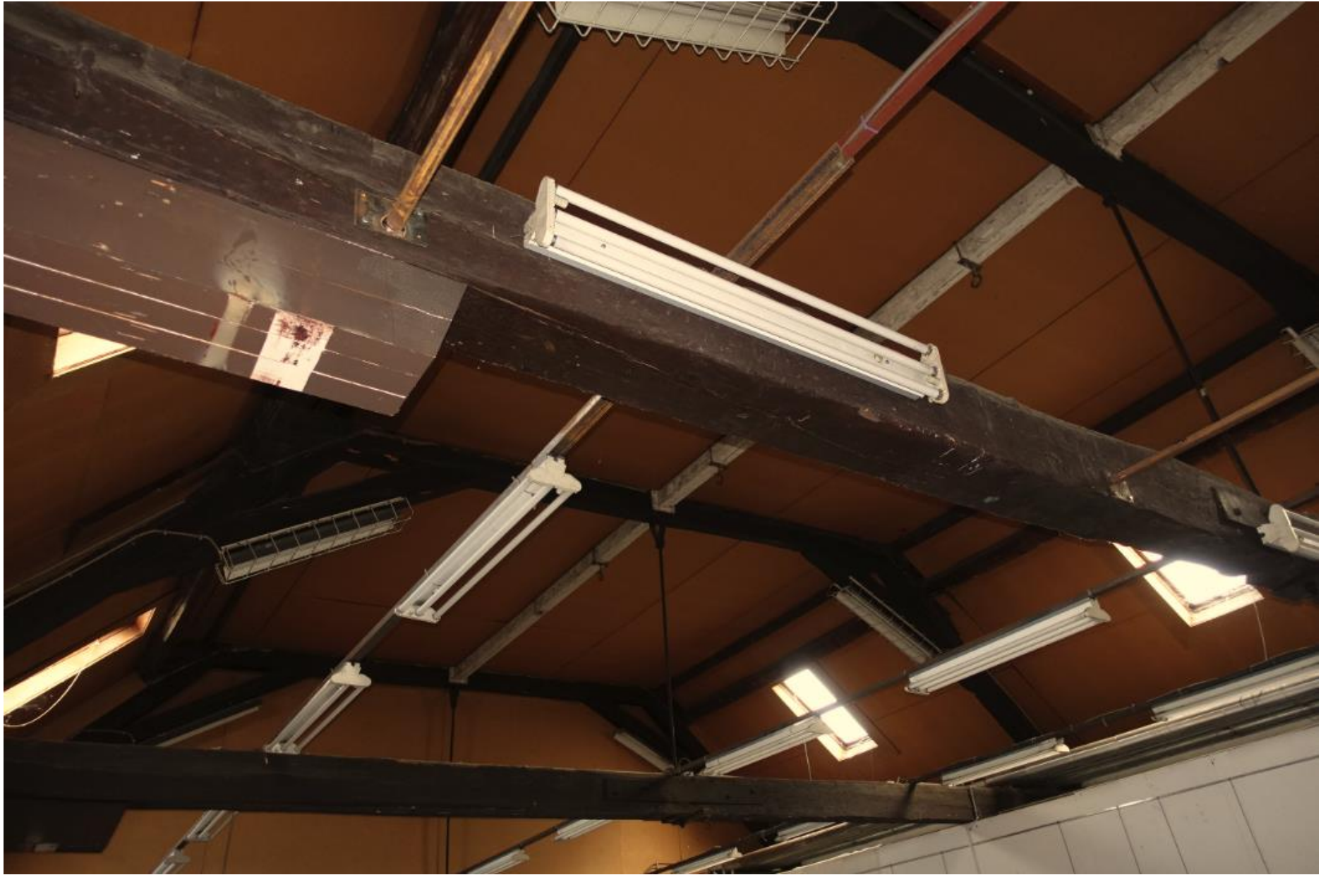
De spanten boven het voormalige gymnastieklokaal (ruimte I, zie ruimte indeling hoofdstuk 3) gezien naar het noorden.
