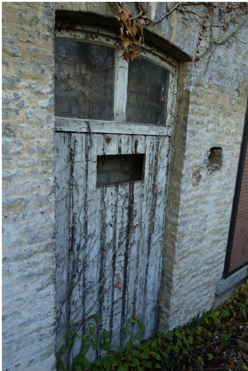
Fig. 19 Een opgeklampte deur uit 1940.
